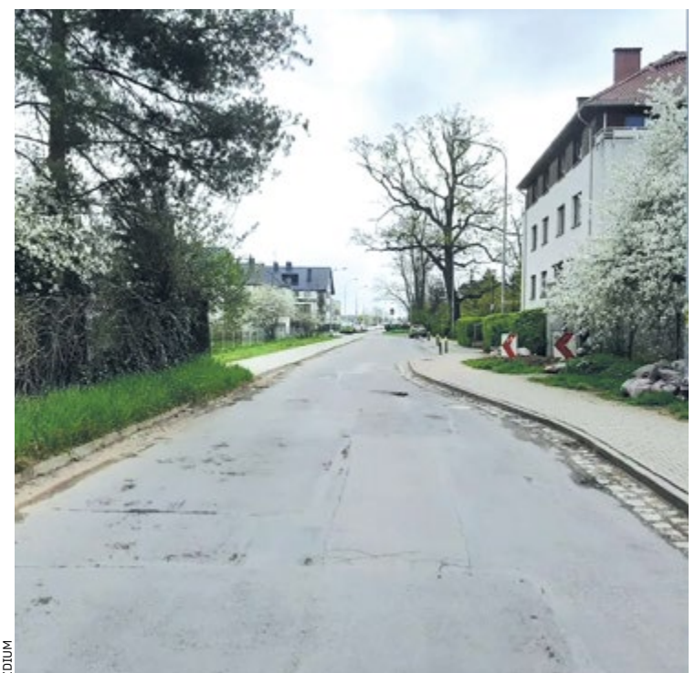
Ulica Asfaltowa zostanie wyremontowana w dwóch etapach
